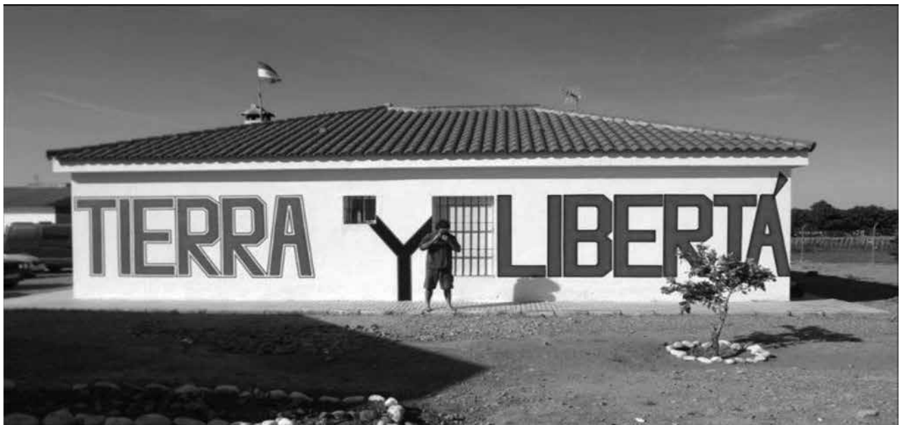
FIGURA 1. VISTA DE LA CASA PRINCIPAL EN EL CORTIJO DE SOMONTE
